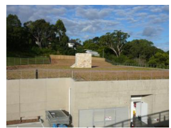
Eingang zur Filteranlage
